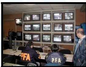
Sala de control operativo con equipos de filmación de los estadios de Boca Jrs. Y River Plate (Bs. As. - Argentina). Fotos arq. Agustín García Puga ®
